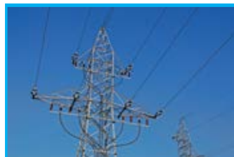
Automatizacija vodova – ugradnja recloser-a
